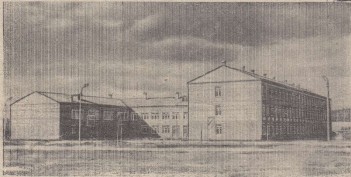
На снимке: здание Дзержинской средней школы имени Ракуса, построенное рабочими ПМК-9. Фото В. СТРЕПЕТКОВА.
